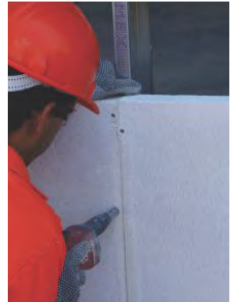
Fig. 11 Colocación de tornillos en unión.
