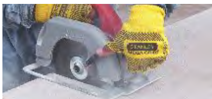
Fig. 14 Corte de Hebel® Power Panel.
